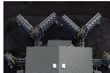
CO 2 Kollektoren und Prozesshalle
